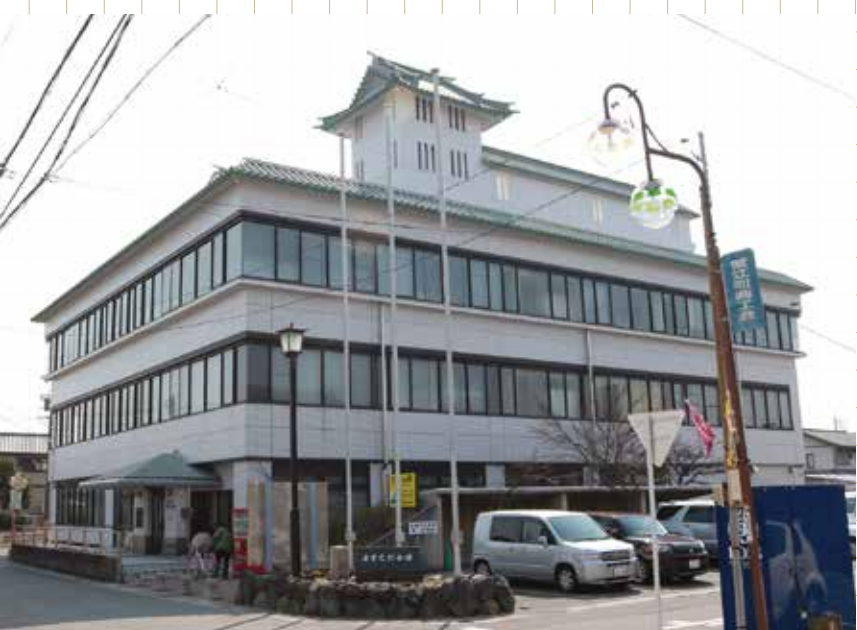
■お城のような屋根の外観が特徴の建物
