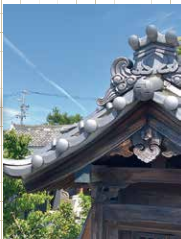
■堤防の上の祠も、立派な建造物
